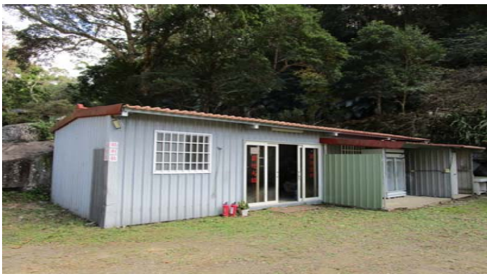
[完全固定]管理室
